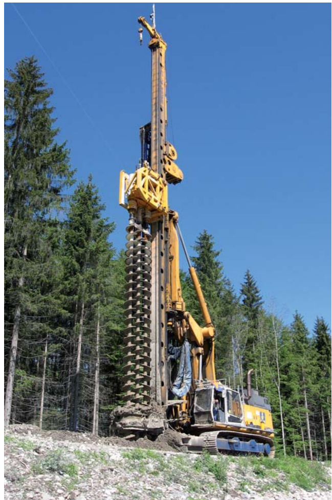
Het aanbrengen van de MIP-wand in beperkte ruimte
