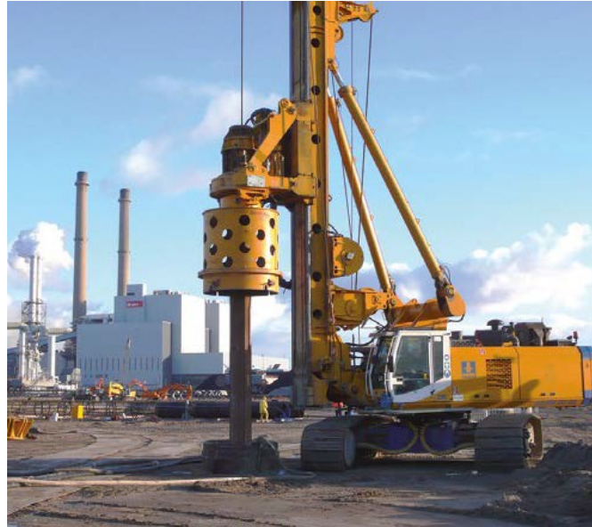
Grootdiameter boorpalen, MPP3, Maasvlakte
